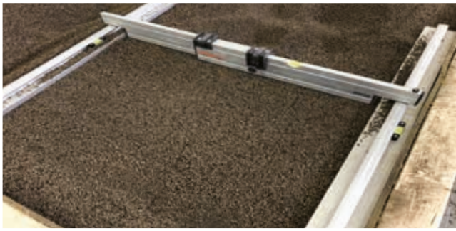
Stesura del sottofondo a secco in PaviLeca e livellamento.
