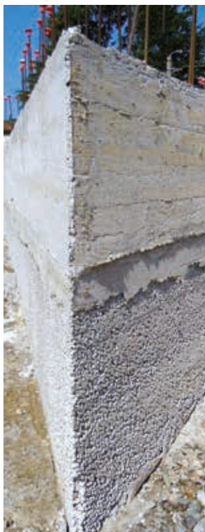
Isolamento termico della platea di fondazione in Leca TermoPiù cementato e in sacco.
