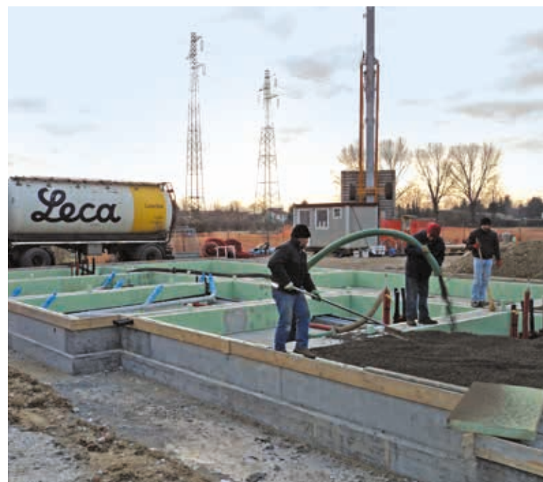
Isolamento termico contro terra in Leca TermoPiù sfuso pompato.
