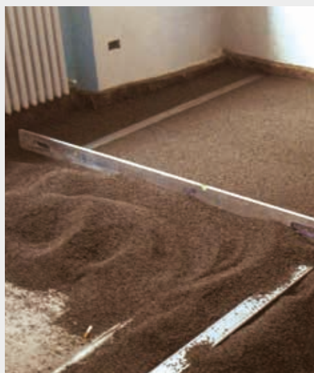
Livellamento del riempimento con staggia.
