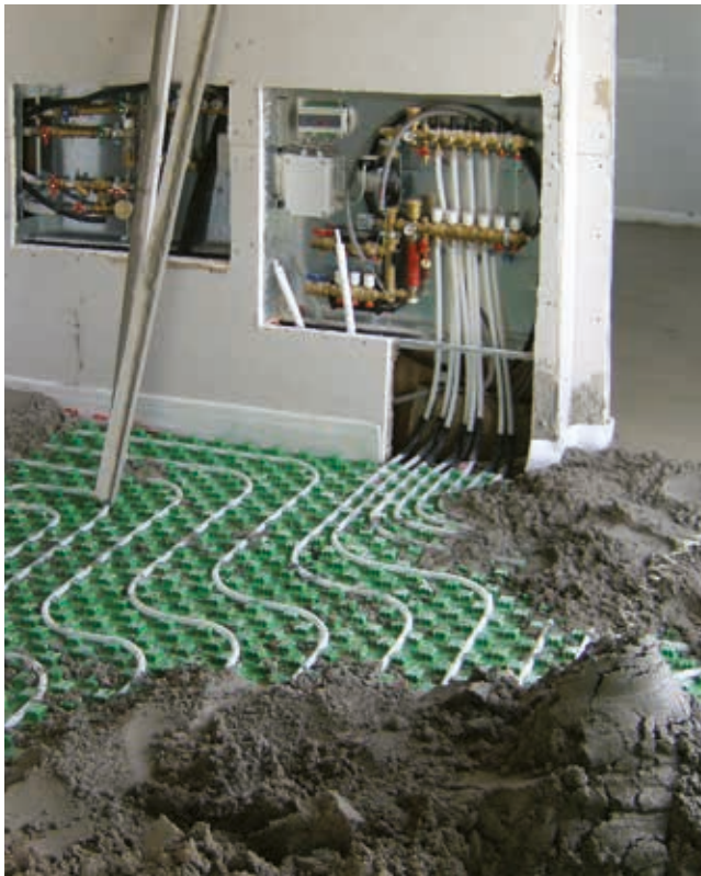
Massetto radiante fibrorinforzato a elevata conducibilità termica antiritiro e basso spessore PaRis 2.0.
