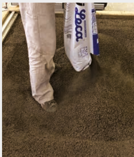
Riempimento tra le guide di riferimento con il PaviLeca.
