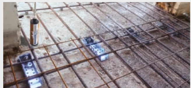
Perimetro Forte è l'innovativo sistema di cerchiatura perimetrale con funzione antisismica composto da Connettore Perimetrale e Ancorante Chimico.
