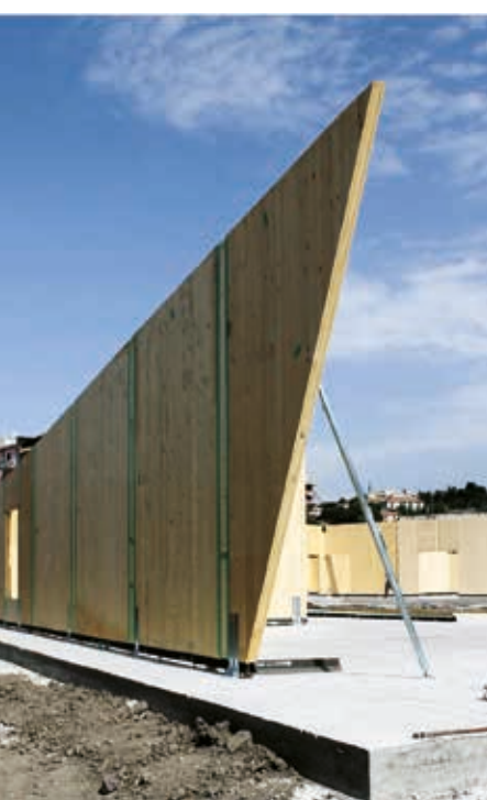
Sistema costruttivo X-LAM.
