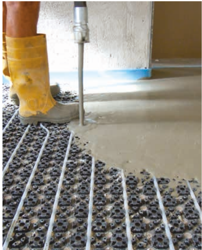
Massetto autolivellante antiritiro e a basso spessore per pavimenti riscaldati PaRis SLIM.
