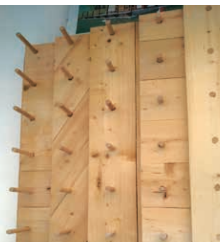
Sistema senza colle (a pannello chiodato).
