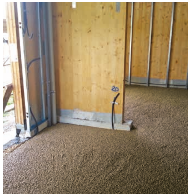
Isolamento termico contro terra in Leca TermoPiù sfuso.
