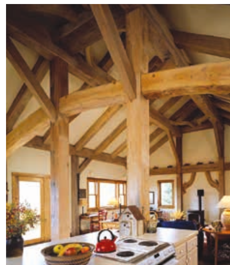
Sistema costruttivo Post and Beam.
