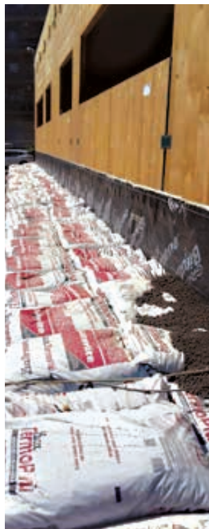
Isolamento termico della platea di fondazione in Leca TermoPiù cementato e in sacco.
