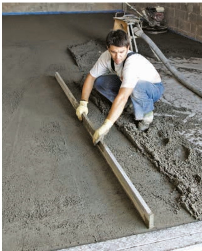
Massetto di finitura in Lecamix, per strati di finitura isolanti e a veloce asciugatura.
