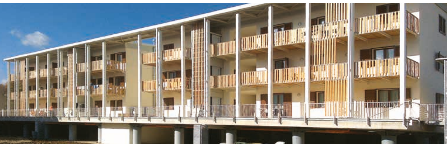
Moduli residenziali a L'Aquila post terremoto: il sistema costruttivo in legno è stato scelto per velocità nella realizzazione.
